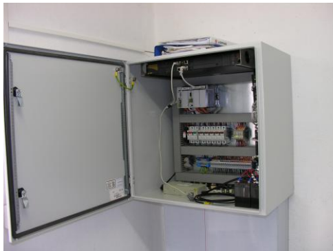
Slika 3: Postavitve sistema poenotene komunikacije ter univerzalne RTU naprave na TP Almira
